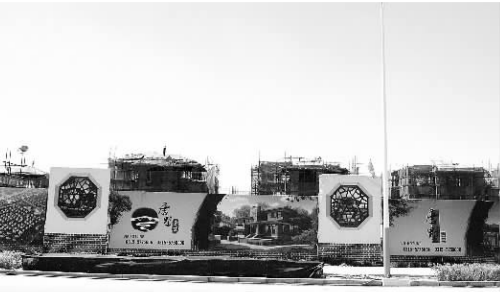
图为正在建设中的“唐墅壹号”别墅。
