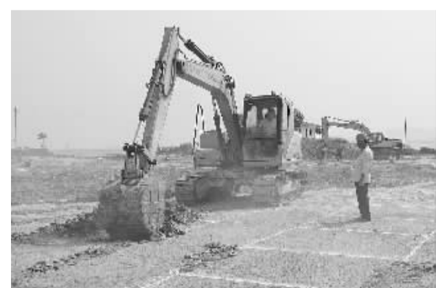
7月30日,安徽升金湖湿地生态科普中心建设工程开工。该项目总投资2900万元,土建工程力争今年年底完工,整个工程计划在2012年底前竣工。 张剑 摄
