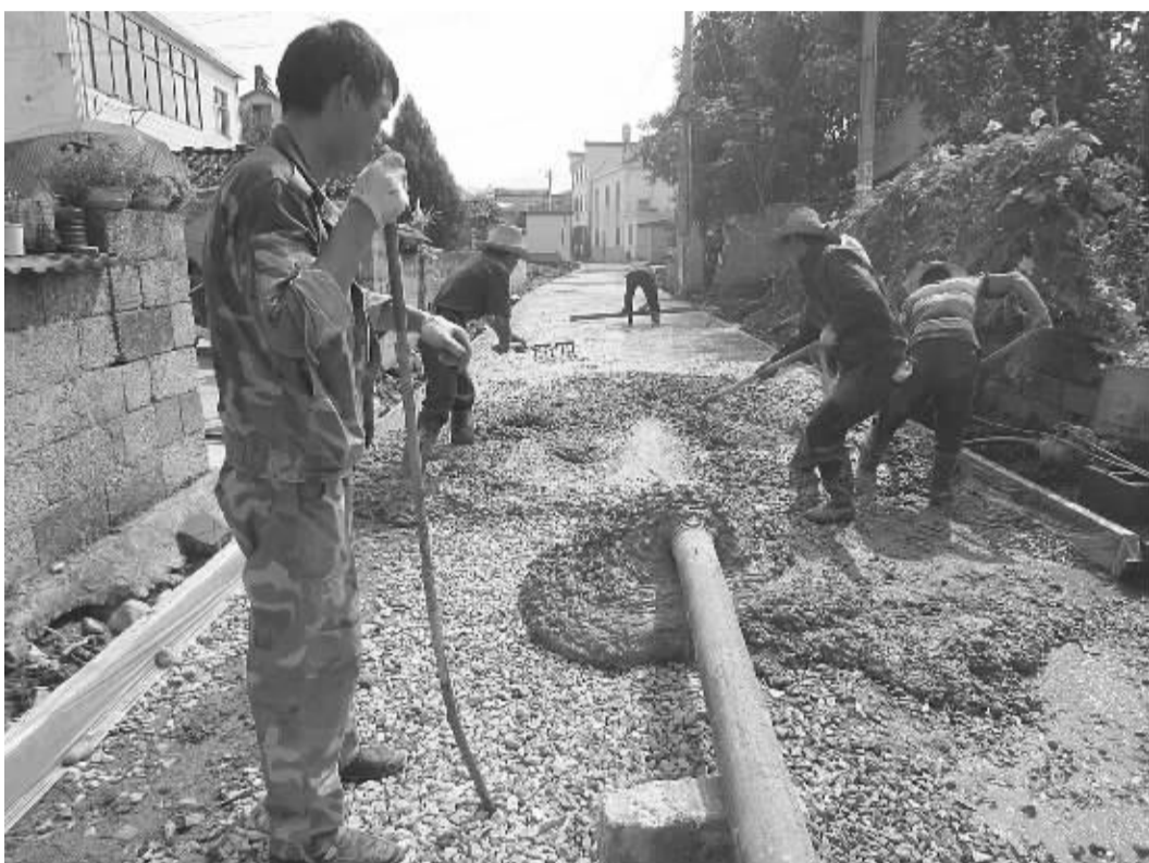
九华山风景区九华乡加大农村环境综合整治的力度。图为施工工人正抓住晴好有利天气,加快村庄雨污管网及道路建设项目的施工。
