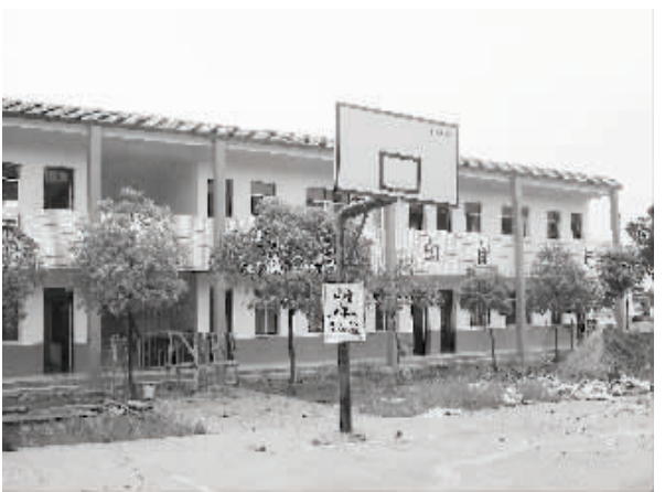
日前,贵池区牛头山中心小学8幢教学楼、总面积5300平方米的加固改造校安工程全部竣工,是我市首个率先完成校安工程暑期加固施工任务的学校。记者 余永平摄
